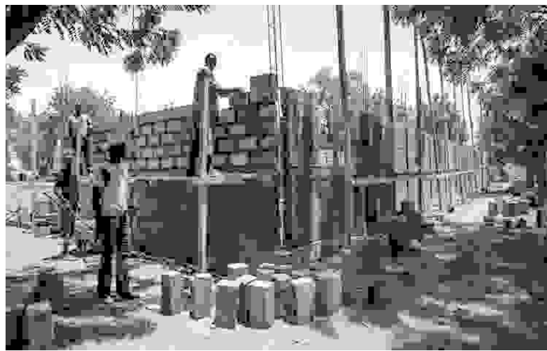
foto: budowa szkoły w Bousso
